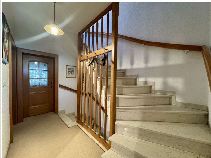
Treppe EG - OG
